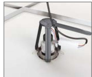
4. Conecte la fuente de alimentación y fije el cable en el retenedor.
